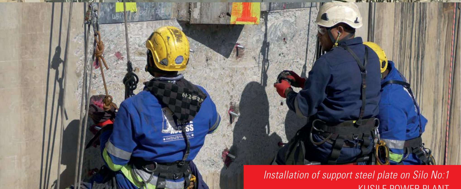
Silo No:1 KUSILE POWER PLANT
